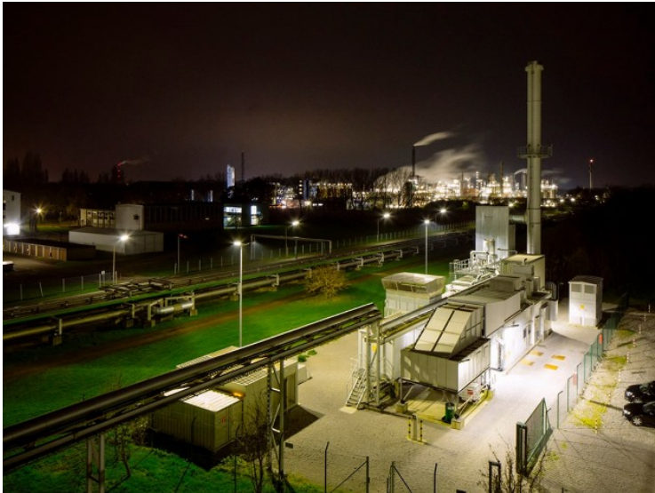
(MAN_MGT_1.jpg) Wie bei dieser Anlage in Rheinberg (Deutschland) liefern die MGT-Turbinen Strom und Wärme im hocheffizienten KWK-Betrieb.
